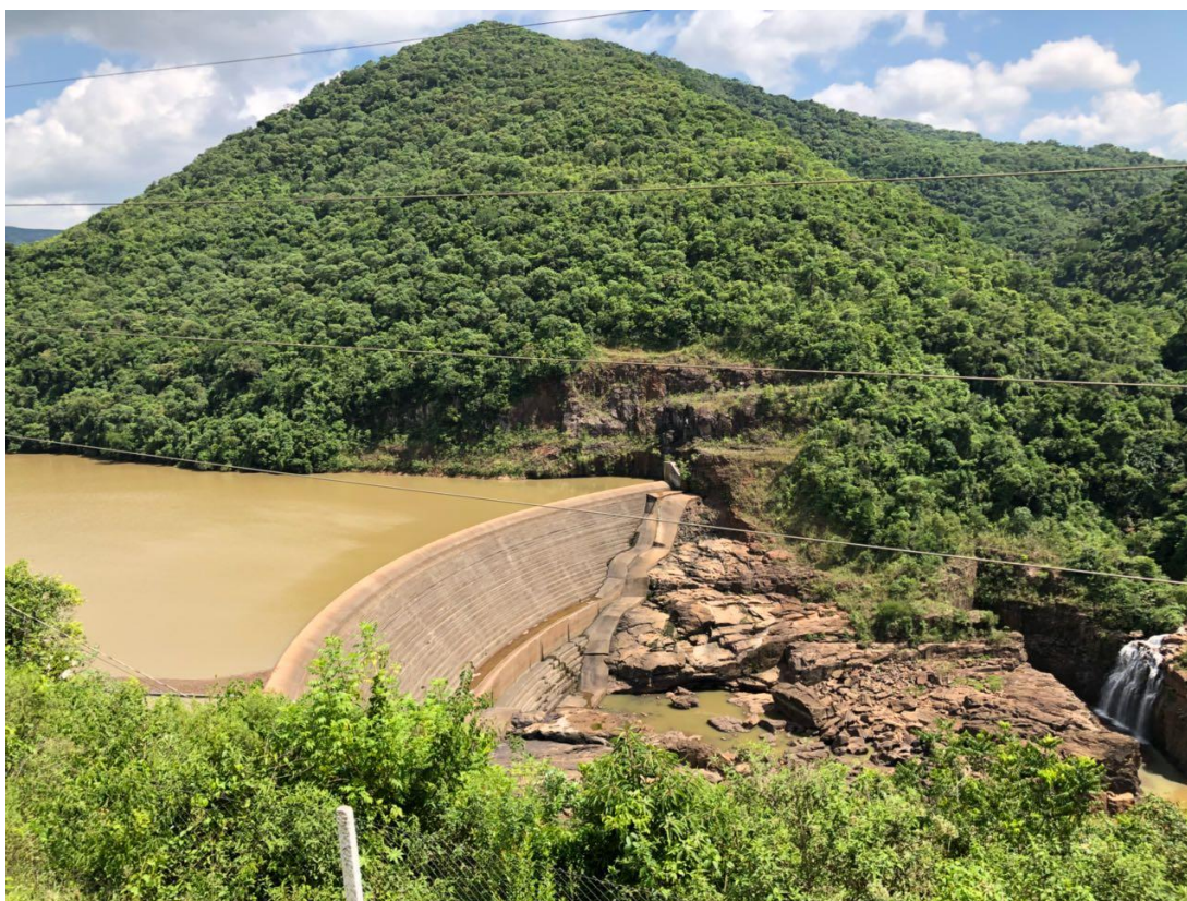
Figura 1 – Vista Geral da Barragem da PCH Linha Emília
